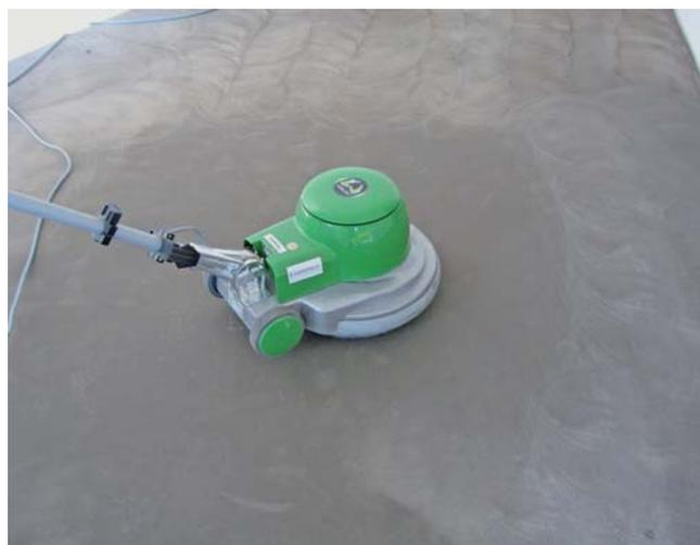
Si la pose doit intervenir plus de 2 heures après enduction, le Ragréage rapide peut être facilement poncé. Malgré sa grande résistance, un ponçage rapide et intensif reste possible entre 2h30 et 4 heures après application.
