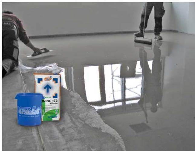
Le Ragréage rapide UZIN NC 172 BiTurbo présente la meilleure propriété autolissante de sa catégorie, sa durée pratique d'utilisation est suffisamment longue et il est pourtant recouvrable après 60 minutes. La photo montre l'application dans une construction neuve, dans laquelle – dans de mauvaises conditions climatiques – une recouvrabilité rapide est impérative.
